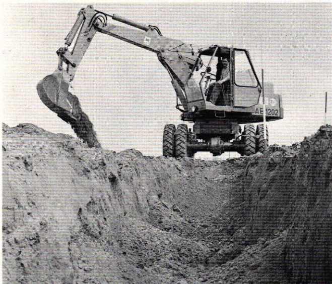
ATLAS-Mobilbagger 1202 mit Tieflöffel beim Fundamentaushub
