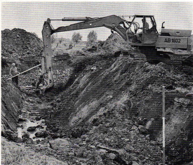
ATLAS-Raupenbagger 1602 mit Grabenlöffel
