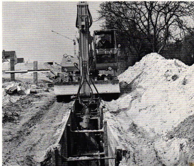
ATLAS-Mobilbagger 1302 mit Planier- und Abstützschild, Grabenaushub mit Greifer
