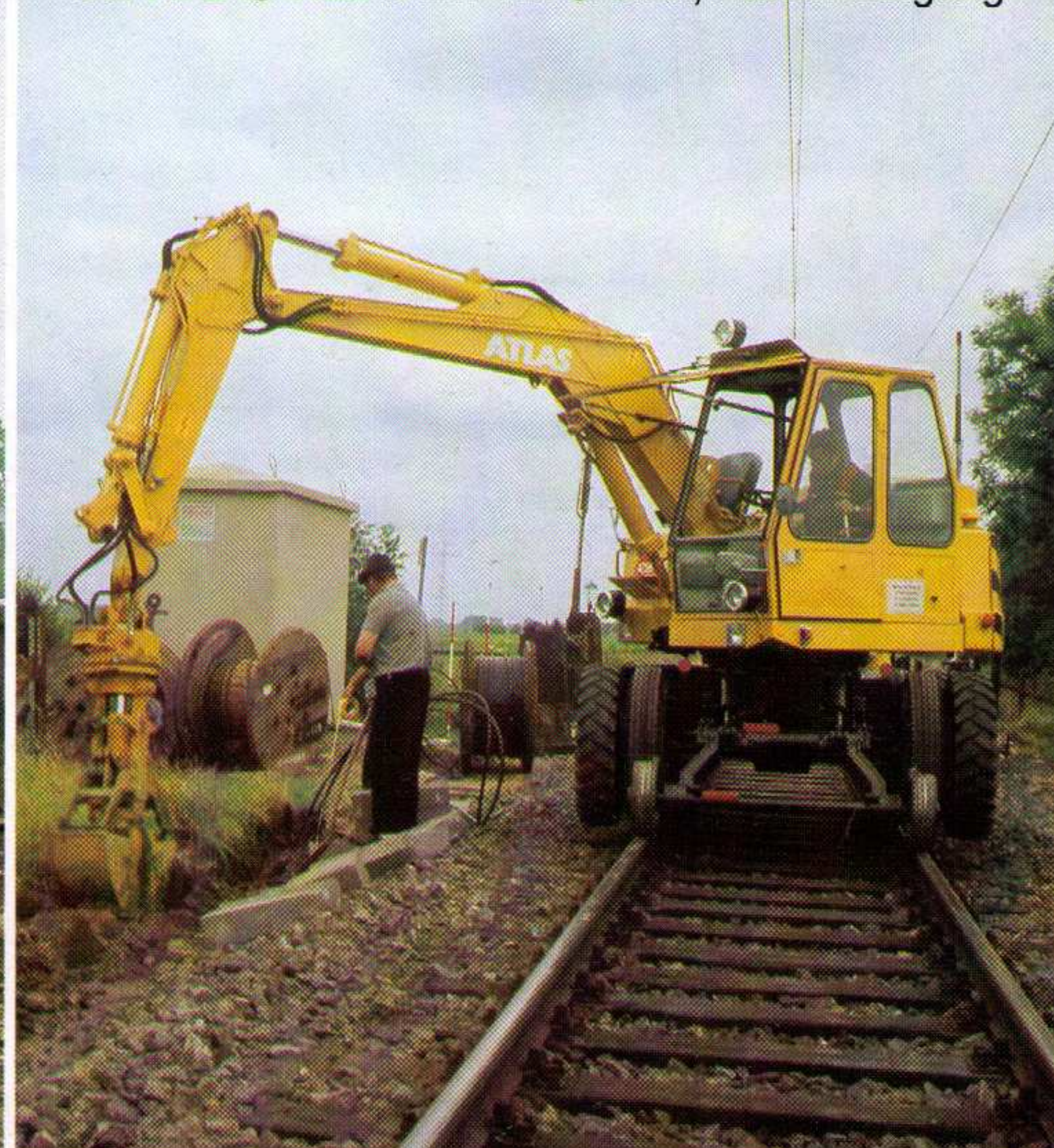
Der ATLAS 1122 D ZW mit Greifer, Kabelverlegung
