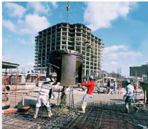
Hoch- und Tiefbau
