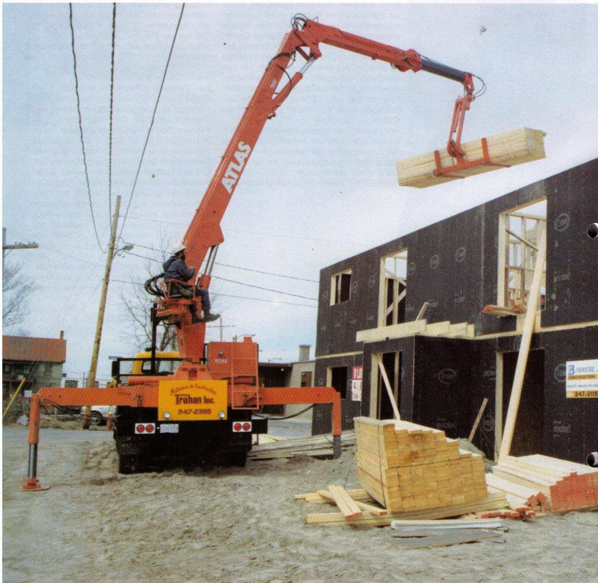
Überwiegend für schwere Montagearbeiten im Stahl-, Hoch-, Fertighaus- oder Fassadenbau werden ATLAS Krane der Typenreihe 6002 eingesetzt. Durch den abknickbaren Ausleger und den großen hydraulischen Ausschub des Knickarmes ist der ATLAS 6002 — ein Kran der Größenklasse bis 290 kNm (29mt) — in der Lage, schwere und/oder sperrige Güter in Etagen oder Geschosse hinauzuheben, ein wesentlicher Vorteil gegenüber dem starren Teleskopkran.
