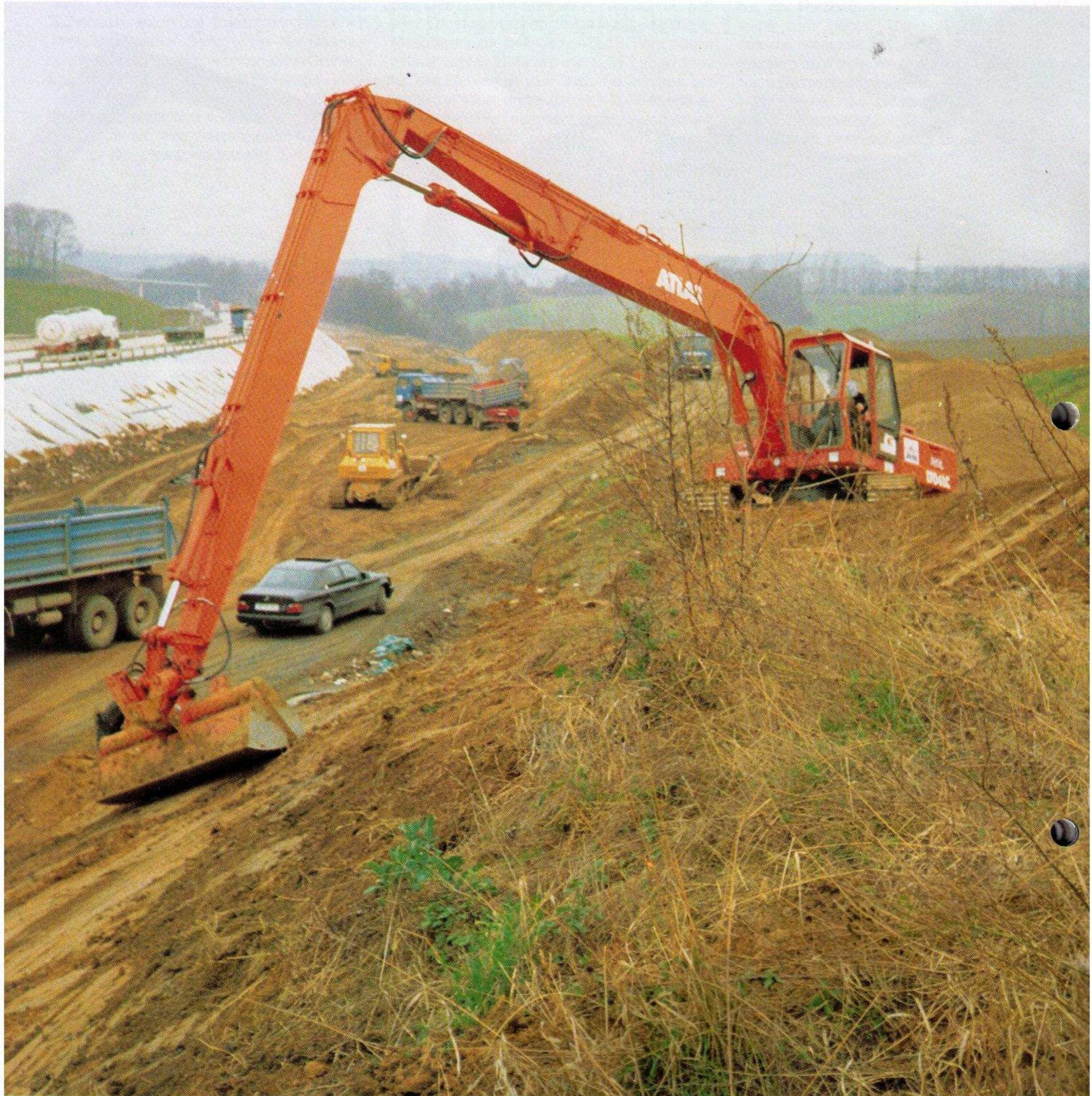
Immer häufiger werden ATLAS Bagger für Böschungsarbeiten eingesetzt, ob bei Erstellung oder Erneuerung von Wasserwegen oder beim Böschungsbau an Verkehrsstraßen. An der Autobahn A3 beim Hildener Kreuz werden zur Zeit umfangreiche Arbeiten wie Verbreiterung der Fahrbahnen bzw. Neuanlegung von Böschungen, teilweise mit Terrasse, durchgeführt. Für diese Arbeiten sind mehrere ATLAS Hydraulikbagger im Einsatz, unter anderem ein ATLAS 1704 LC mit extrem langer
