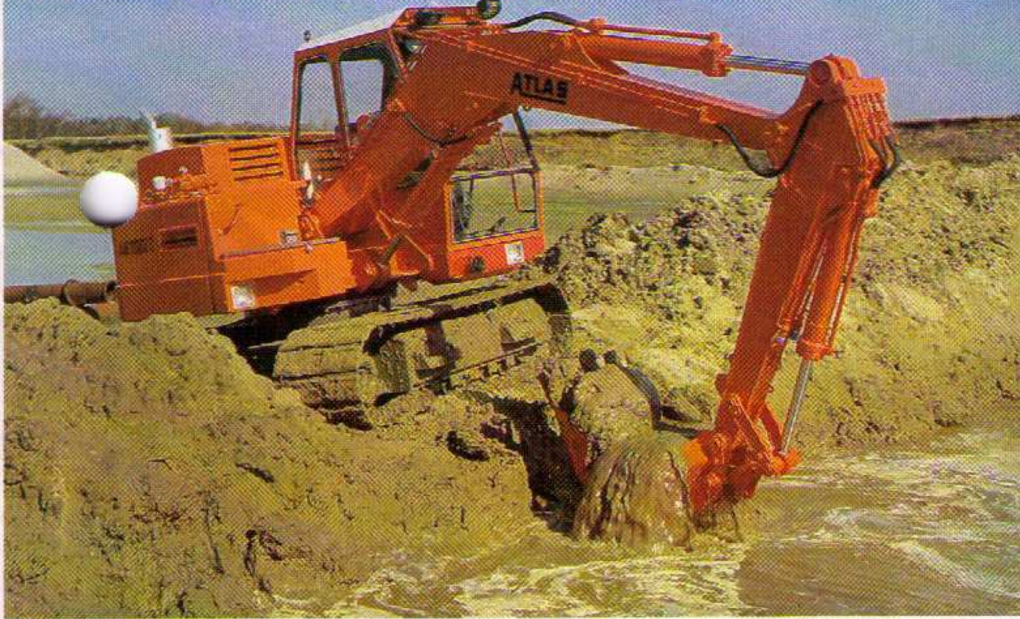
Grabenbau auf weichem Boden
