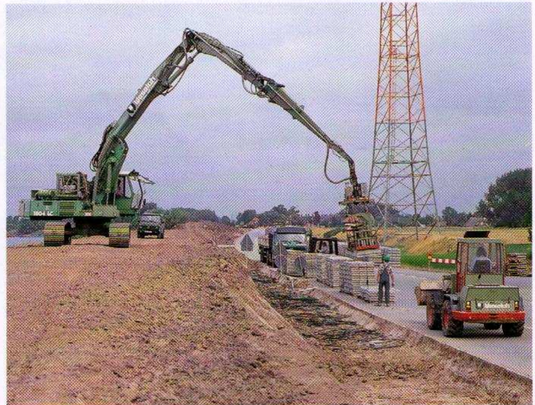
ATLAS 1804 mit Vacuum-Verlegeeinheit.
