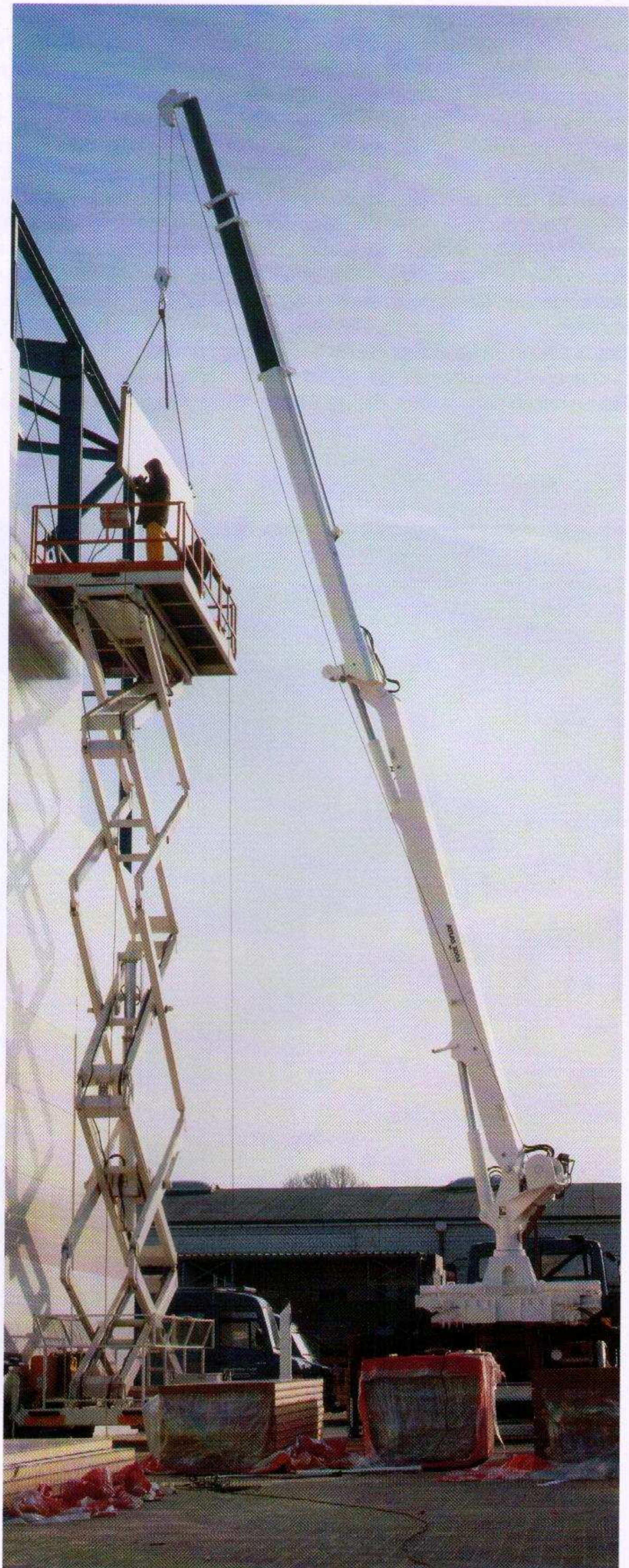
ATLAS Montagekran 300.1 mit Seilwinde und Funkfernsteuerung. Die Reichhöhe beträgt 22 m.
